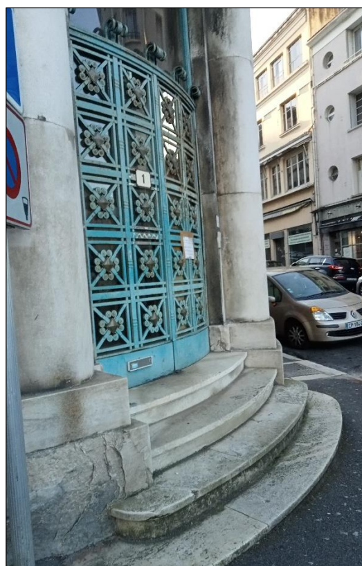
Figure 16 : marches accès CCAS. Source : Gama
