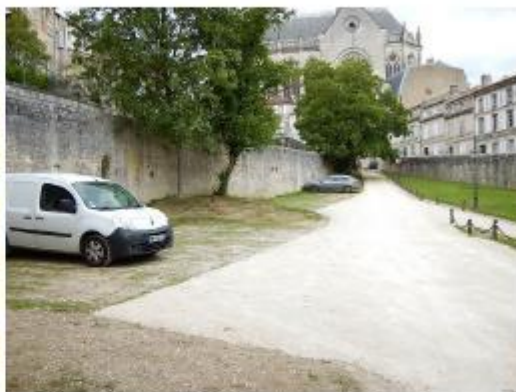
Parking du restaurant Saint-Gelais : allée revêtement sablé stabilisé et places de stationnement encailloutées
