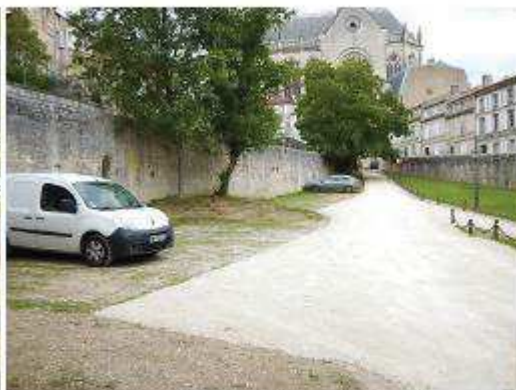
Parking du restaurant Saint-Gelais : allée revêtement sablé stabilisé et places de stationnement encailloutées
