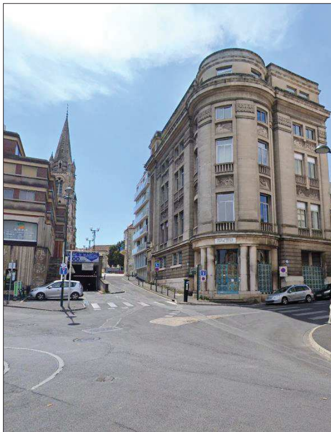
Figure 15 : Immeuble ancien CCAS. Source : Gama
