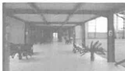
Travée centrale des courts de tennis
